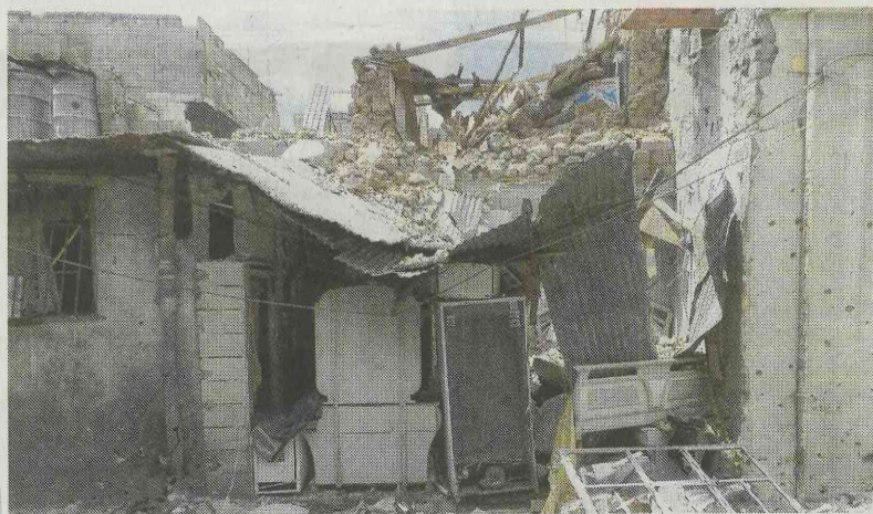
Im syrischen Bürgerkrieg zerstörtes Haus in Homs.
